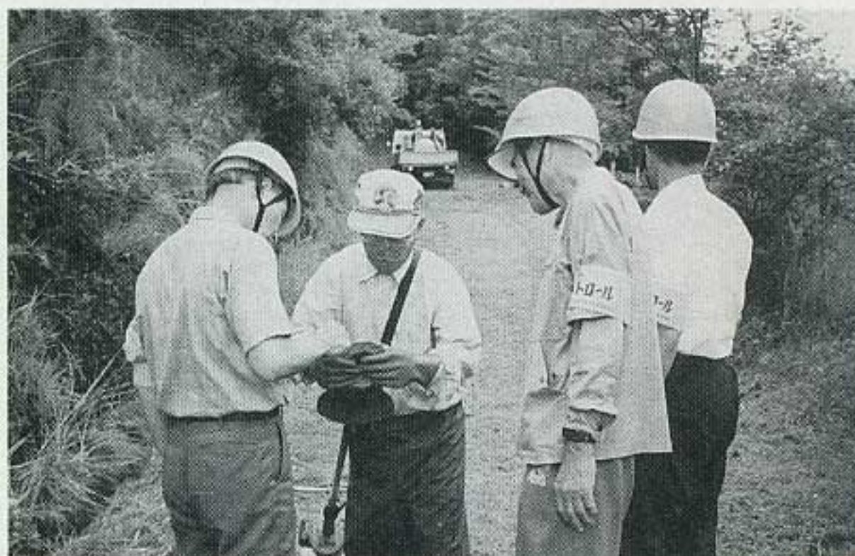
欠け、ひび割れ等の点検！
